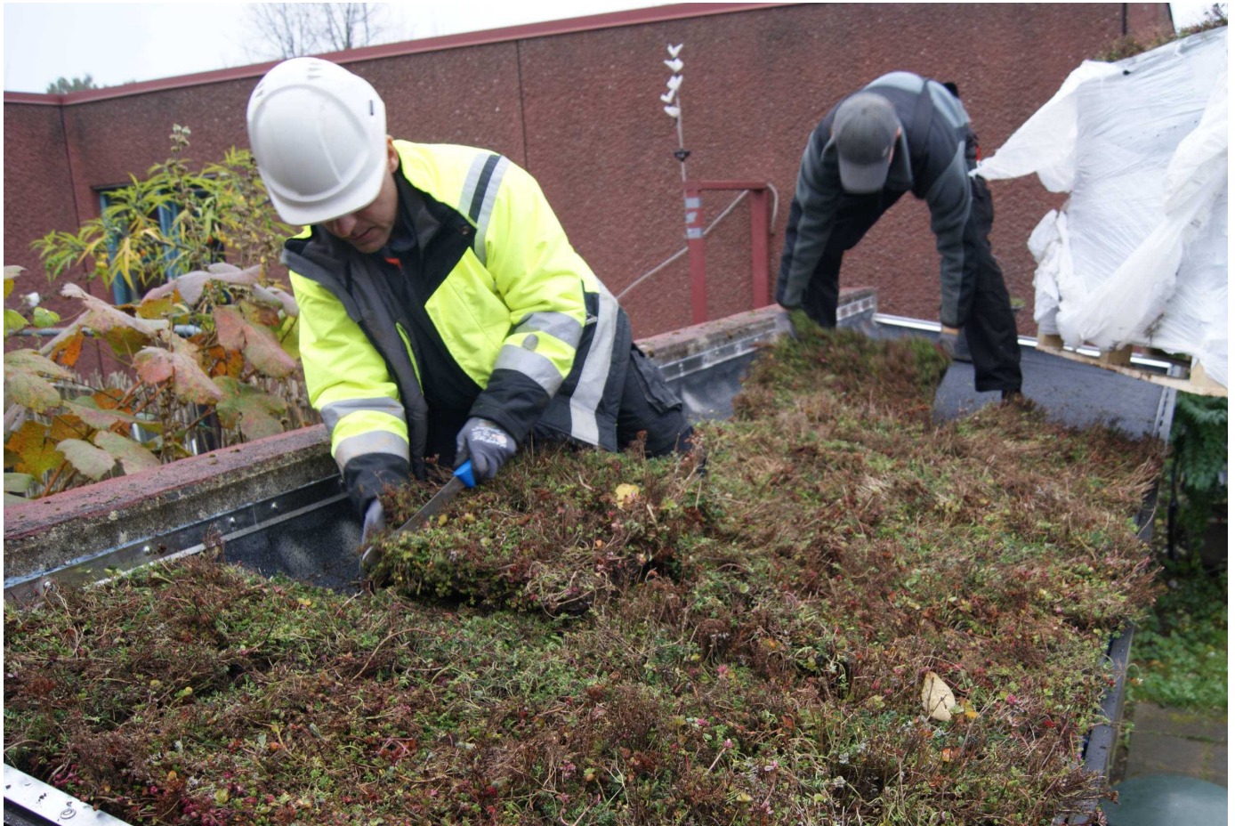
Der lægges grønt tag på i Hyldebjerg. Det er smukt, giver en biologisk zone og tilbageholder regnvand, så kloakkerne ikke flyder over.
